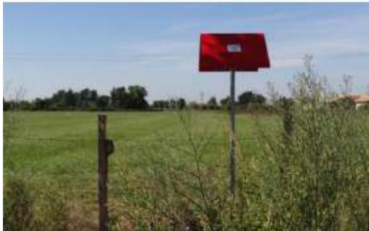
Exemple de balisage existant pour une liaison souterraine. Source : RTE
